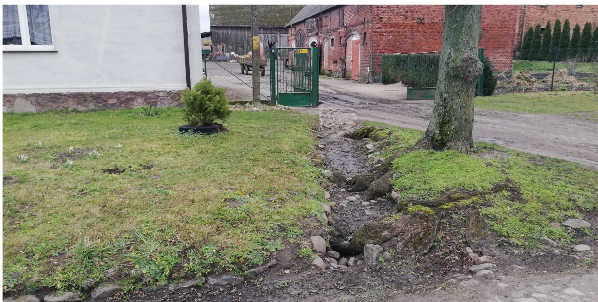
Przykład istniejącego wpustu wymagającego przebudowy
