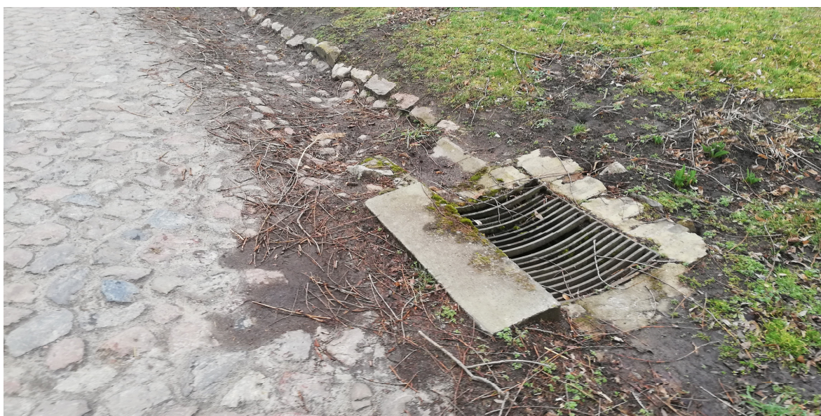
Przykład istniejącego wpustu wymagającego przebudowy
